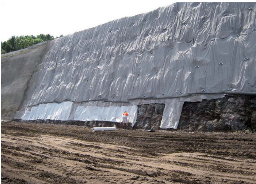
montáž geotextilie a sítě TECCO®
